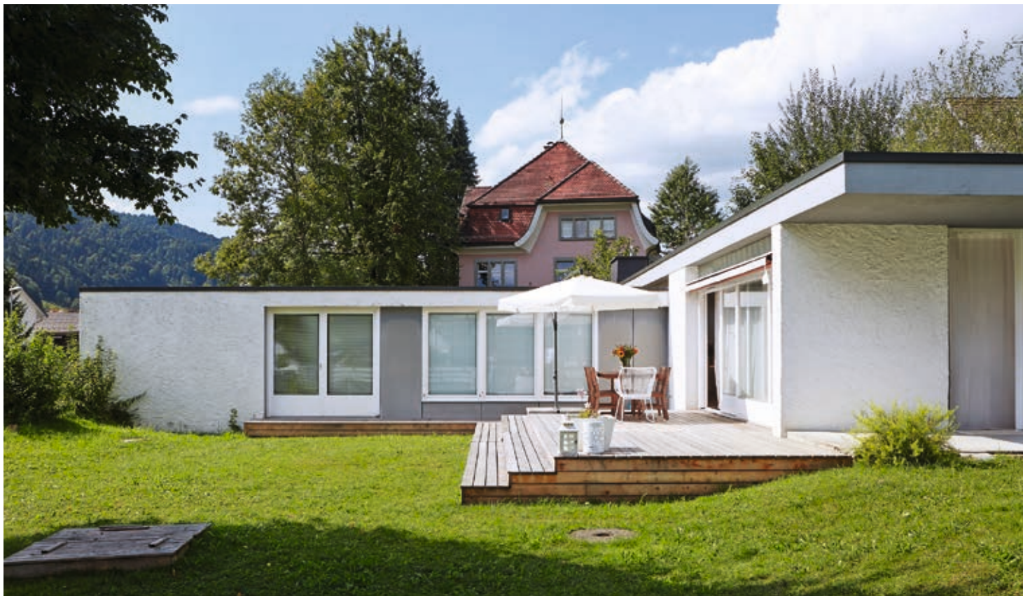
Im Aussenbereich liess der neue Eigentümer eine Terrasse errichten. Als nächstes sollen die Fenster und die Fassade erneuert werden.
